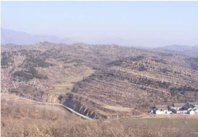
河南濟源山上的「魚鱗坑」 水土流失/工程治理
