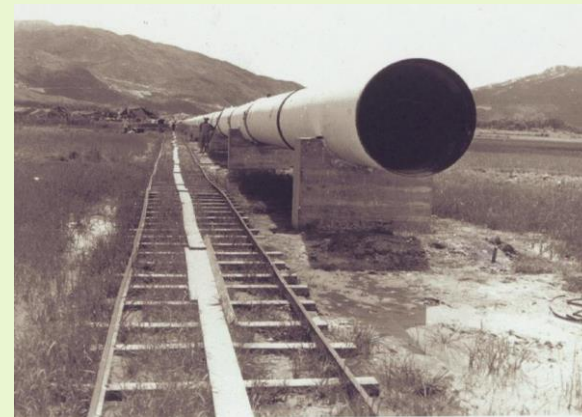
為接收深圳水庫來水，香港在1960年進行鋪設大型水管工程。
