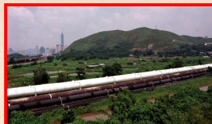
香港輸送東江水的專用管道
