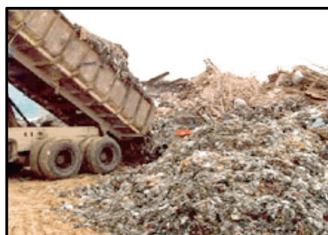
堆填區傾倒建築廢物的情況
