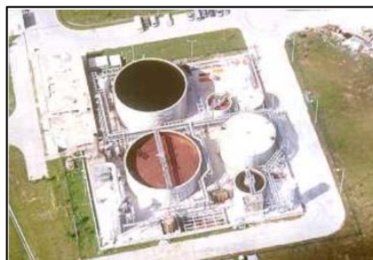
滲濾污水處理設施
