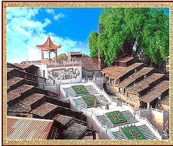
南風古灶有兩座龍窯：南風灶和高灶。據研究分析，高灶的建造年代估計距今大約 400 多年；當時高灶的後面有座香火旺盛的高廟，窯主將龍窯取名高灶。兩座龍窯每年輪流使用，並只在每月 12 日和 28 日裝窯。窯內平面呈船底形，頭、尾略窄而中部稍寬，窯腔似隧道，以小型砂磚結砌而成，頂部為券頂，從窯頭至窯尾共 34 排火眼（投柴孔）。
