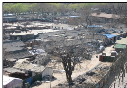
圖三：正在拆卸的北京市四合院建築群。
